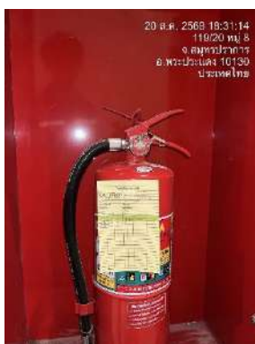
รูปที่ 52 บันทึกการตรวจสอบถังดับเพลิง
